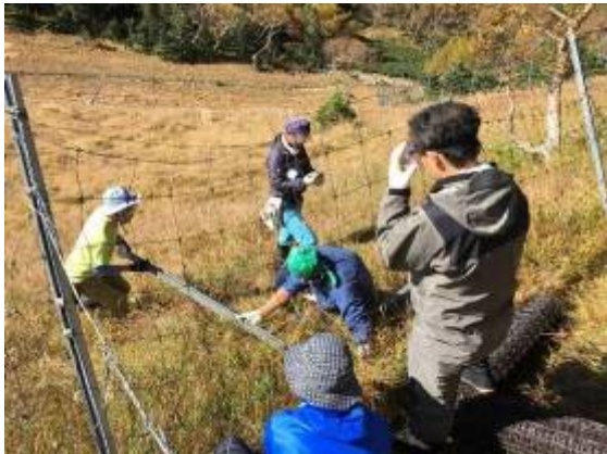
南アルプス（三伏峠）の防護柵設置状況
