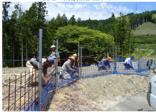
農地の防護柵設置状況
