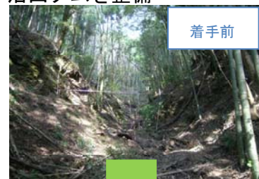
山地災害からの防災・減災対策のため 治山ダムを整備
