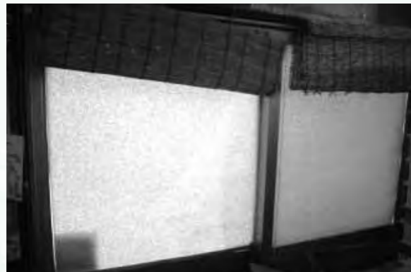
<貼り付けた発泡スチロール>
