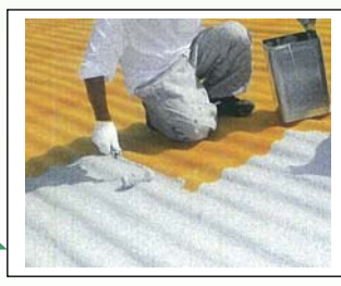
屋根部断熱塗装
