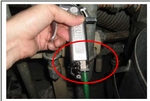
＜エア漏れ部分(リーク検知泡で発見)＞
