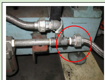
<エア－漏れ修理後>
