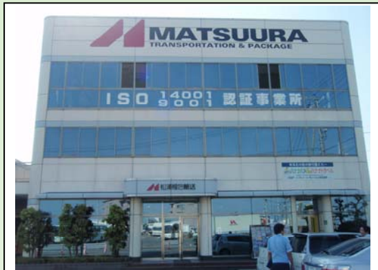
<全ての窓を断熱化>
