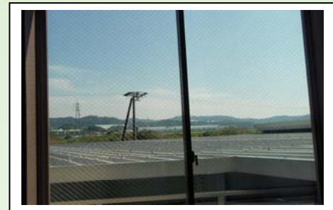
<金網窓には遮熱剤塗布>
