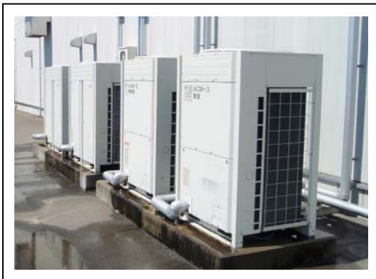
<噴霧装置>一つの室外機につき、1～2箇所噴霧器を設置
