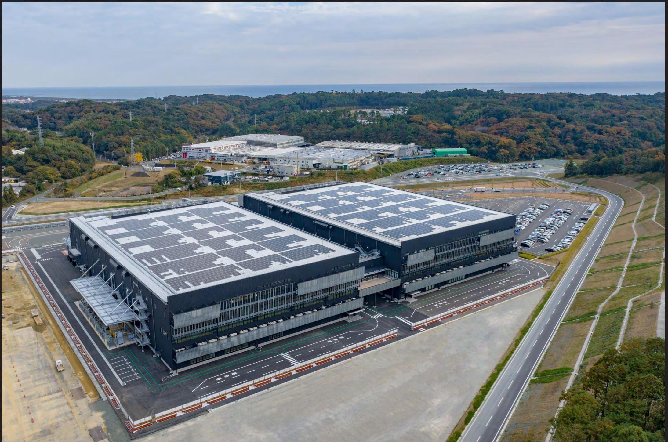
第1工場と第2工場の各屋上にソーラパネルを設置
