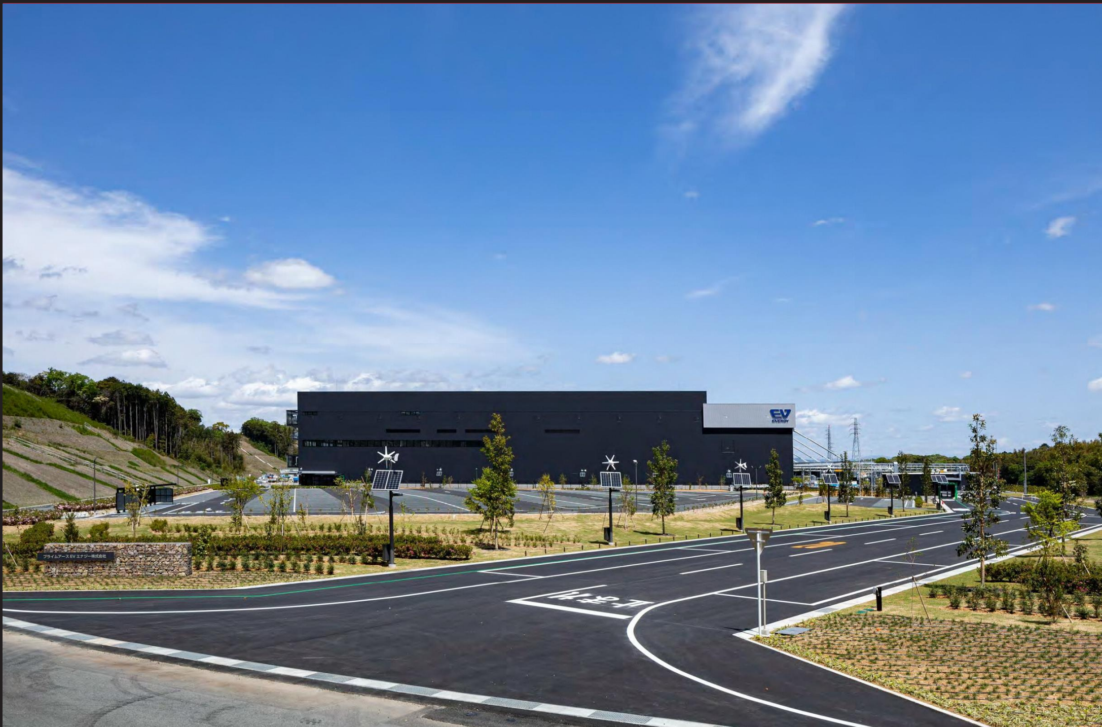
外構は部分的なマウンドアップや樹高の異なる植栽の組合せにより、敷地全体の修景を図る立体感のある計画
