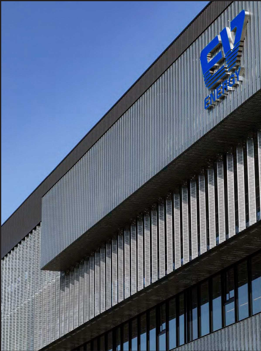
西面のメカニカルバルコニーは、設備機器を集約させメンテナンス性の向上と、2階共用部への日射遮蔽に寄与
