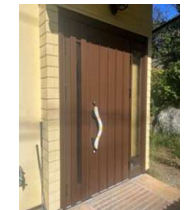
断熱性のある玄関扉への取替え など
