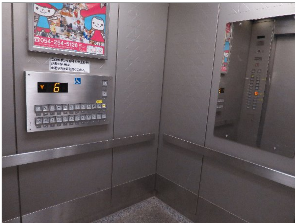
エレベーター
