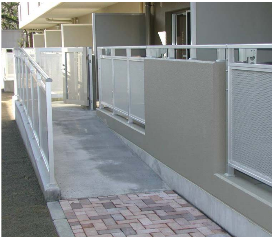
県営住宅へのスロープの設置
