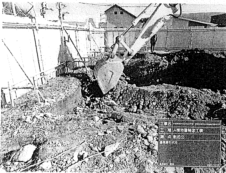
工種：A棟物置解体工事 測点：敷地北
