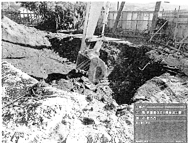
工種：教職員住宅B棟解体工事 測点：敷地西
