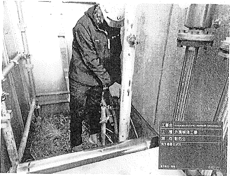
工種：外構解体工事 測点：敷地北
