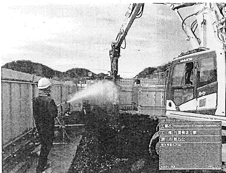
工種：外構解体工事 測点：敷地北
