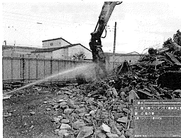
工種：B棟プロパンガス庫解体工 事
