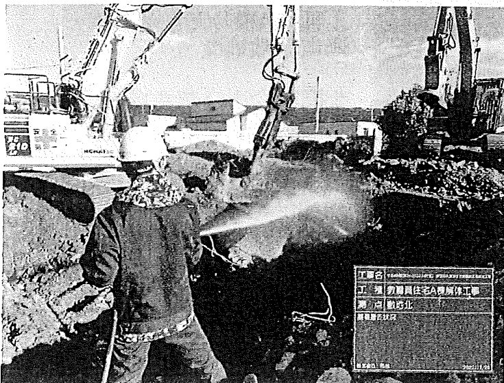
工種：教職員住宅A棟解体工事 測点：敷地北
