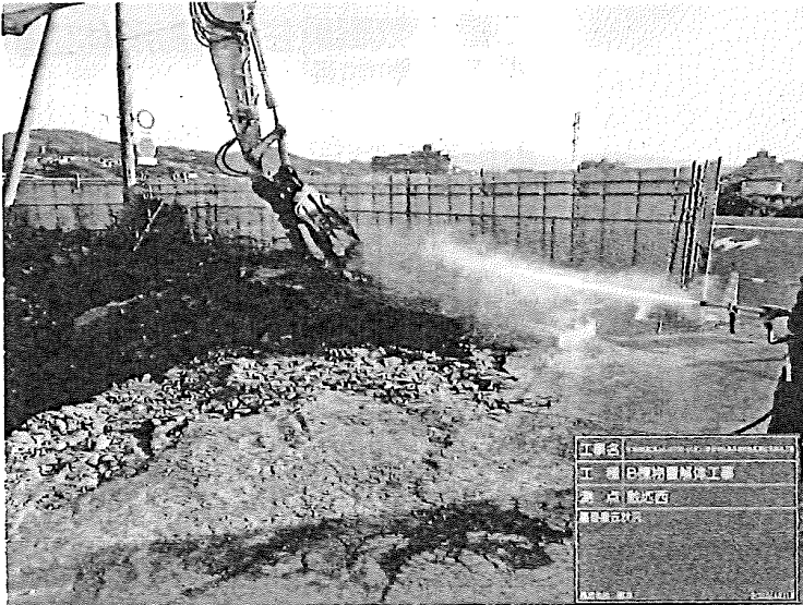
工種：B棟物置解体工事 測点：敷地西
