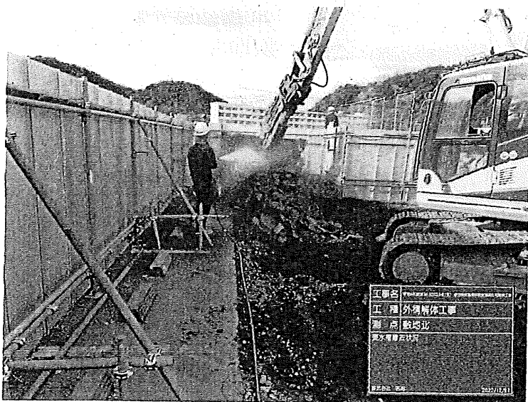
工種：外構解体工事 測点：敷地北
