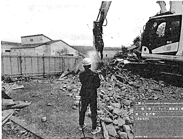
工種：B棟プロパンガス庫解体工 事
