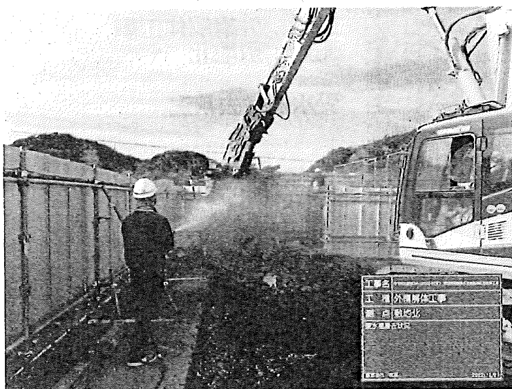
工種：外構解体工事 測点：敷地北
