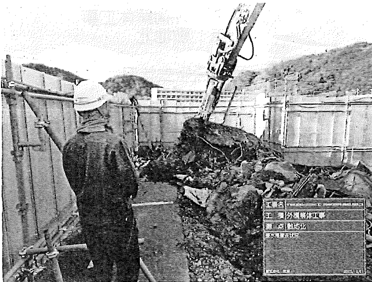
工種：外構解体工事 測点：敷地北
