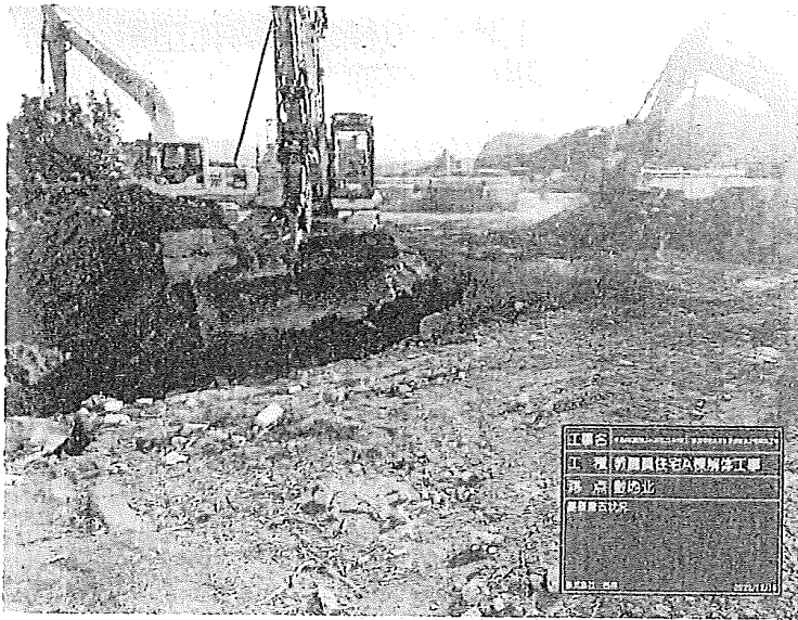
工種：教職員住宅A棟解体工事 測点：敷地北
