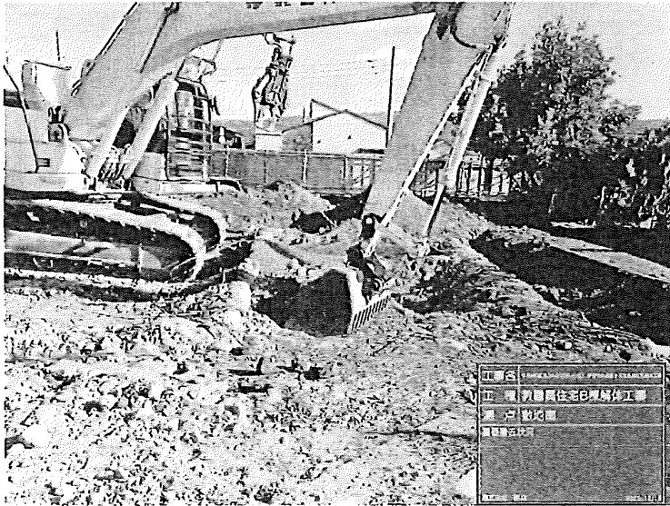
工種：教職員住宅B棟解体工事 測点：敷地南
