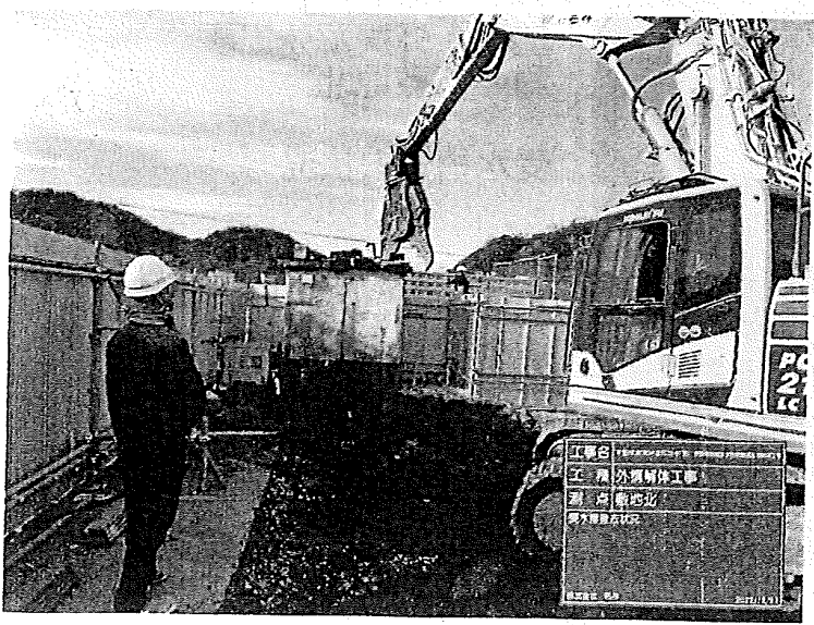
工種：外構解体工事 測点：敷地北
