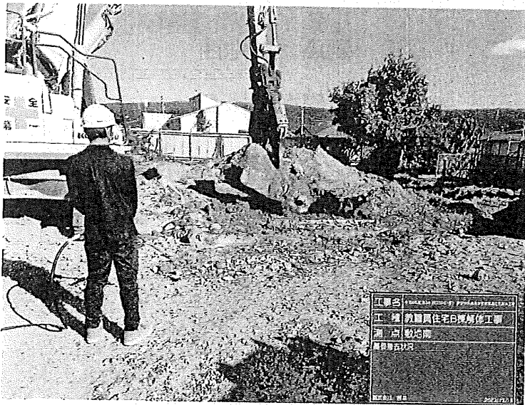
工種：教職員住宅B棟解体工事 測点：敷地南
