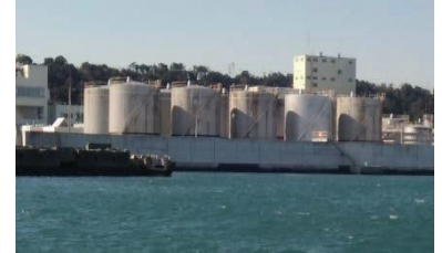
御前崎港海岸防潮堤（胸壁）
