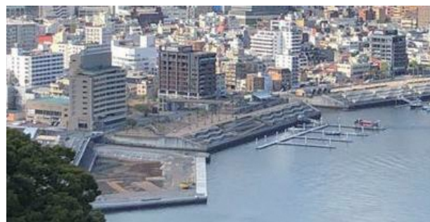
熱海港海岸（海岸堤防）
