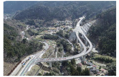
伊豆縦貫自動車道 (河津下田道路（河津七滝 IC）)
