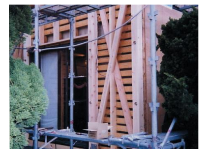
木造住宅耐震改修
