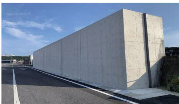
御前崎港海岸（胸壁）
