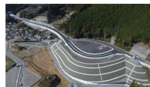
三遠南信自動車道(水窪佐久間道路)
