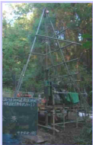
地質調査の状況 (神谷城地区)
