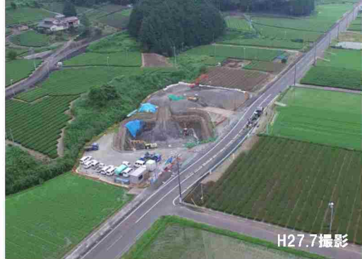
3号橋P3橋脚施工状況
