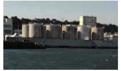
御前崎港防潮堤（胸壁）
