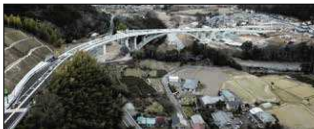
【伊豆縦貫自動車道 天城北道路（H31.1 開通）】
