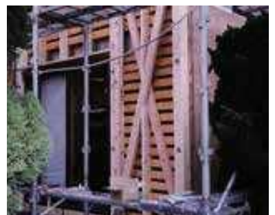
木造住宅耐震補強
