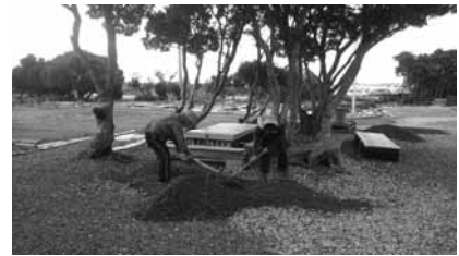
敷均しは会員の人力作業
