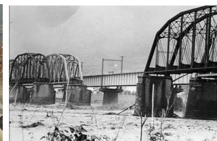
昭和57年の台風で流された 現JRの富士川鉄橋
