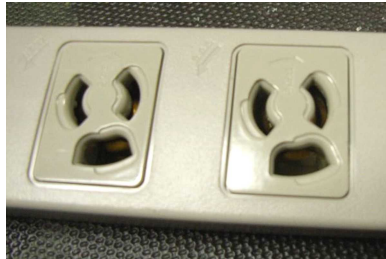
【写真2】東館発電機回路コンセント例
