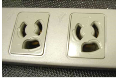
【写真2】東館発電機回路コンセント例
