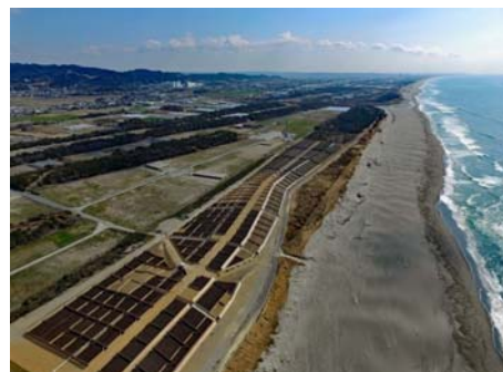
浜松市沿岸域防潮堤整備
