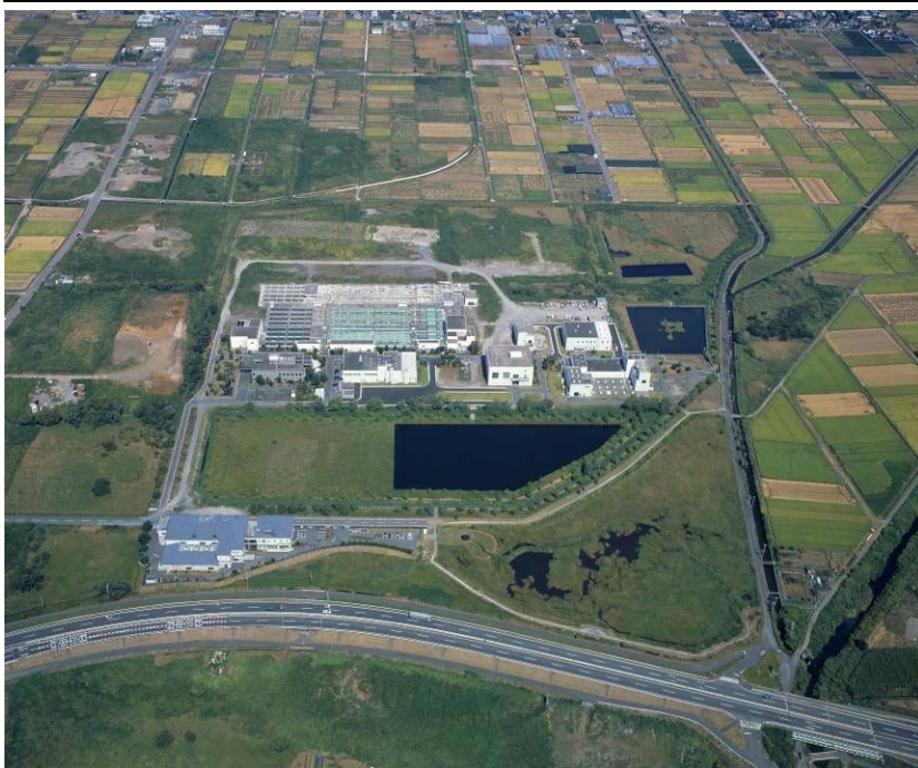
狩野川西部浄化センター
