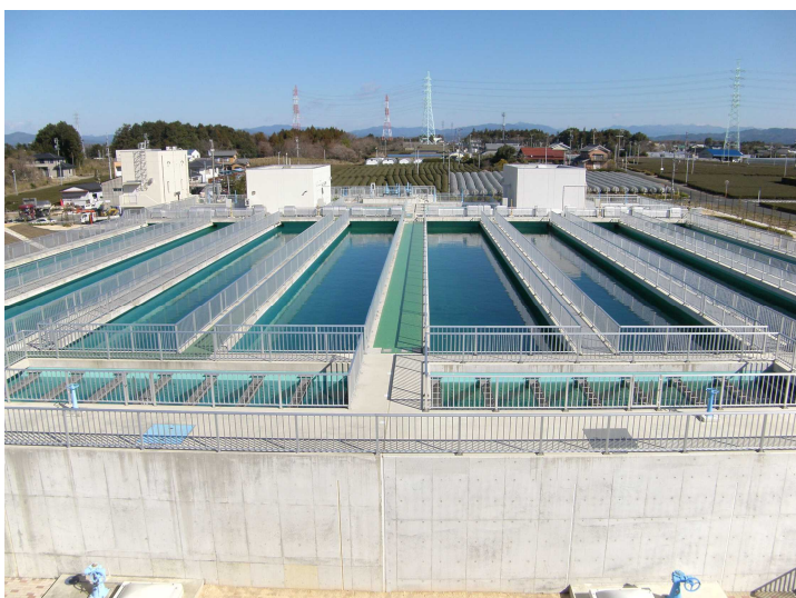
遠州水道 寺谷浄水場
