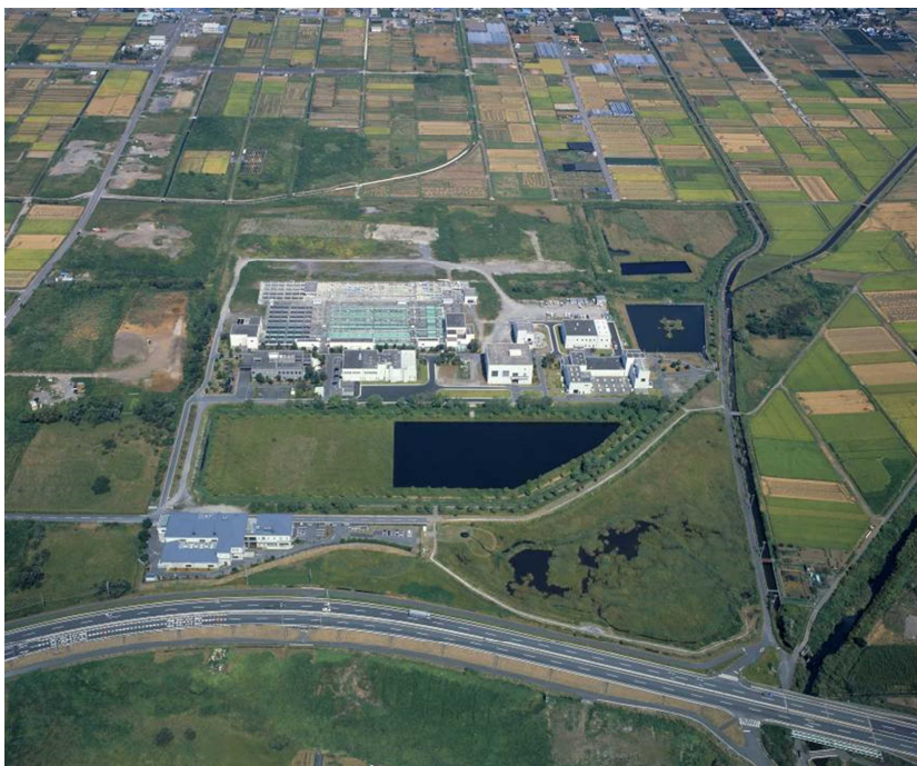
狩野川西部浄化センター
