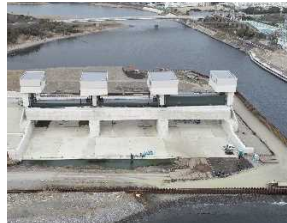
馬込川水門工
