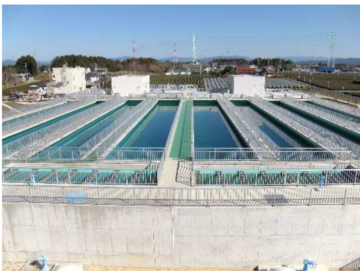
遠州水道 寺谷浄水場
