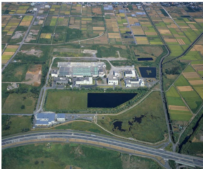
狩野川西部浄化センター
