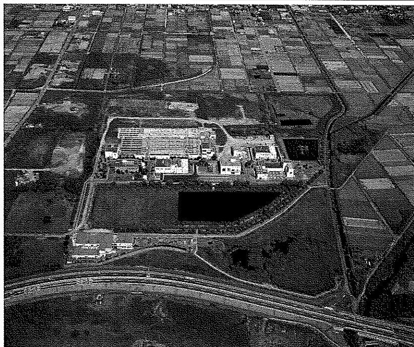
狩野川西部浄化センター
