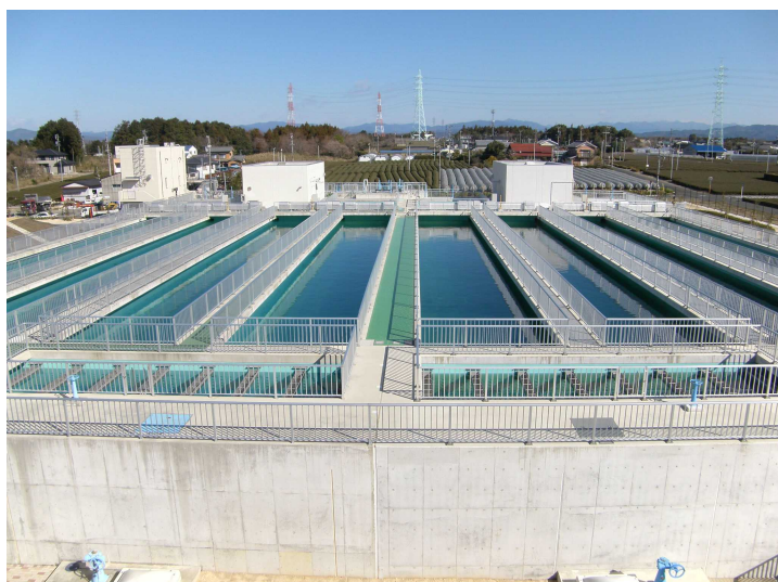
遠州水道 寺谷浄水場
