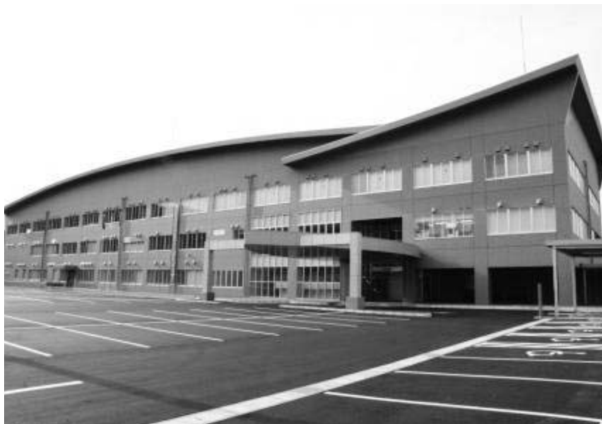
交通安全教育の拠点となる警察施設の整備 (中部運転免許センター)
