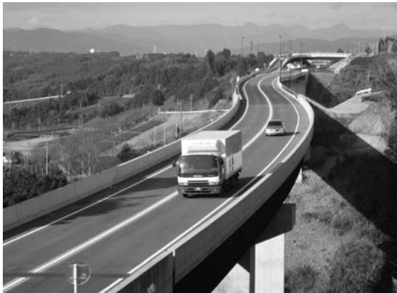
富士山静岡空港へのアクセス道路として供用した国道473号金谷相良道路
