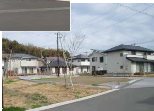
建築が進む 住宅団地(大場)
