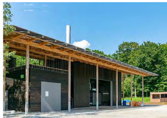
木質バイオマス 発電所
