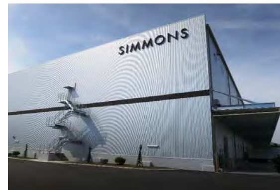
建設された物流施設
