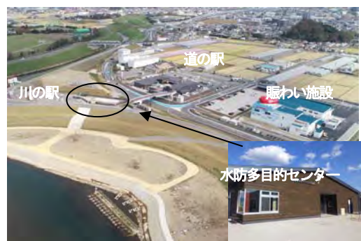
有事の際に防災拠点としての役割を担う道の駅・川の駅（函南町）
