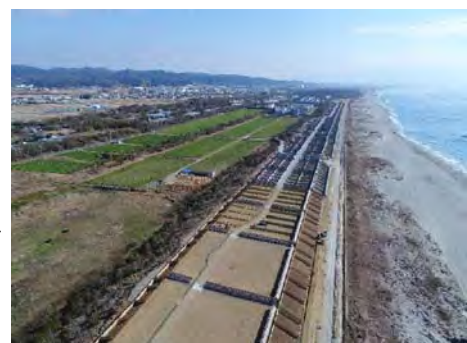
沿岸部の防潮堤の整備（袋井市）
