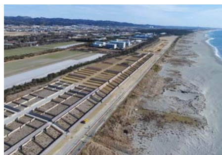
沿岸部の防潮堤の整備（袋井市）
