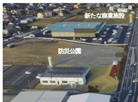
有事の際に防災拠点となる商業施設と防災公園 (吉田町)
