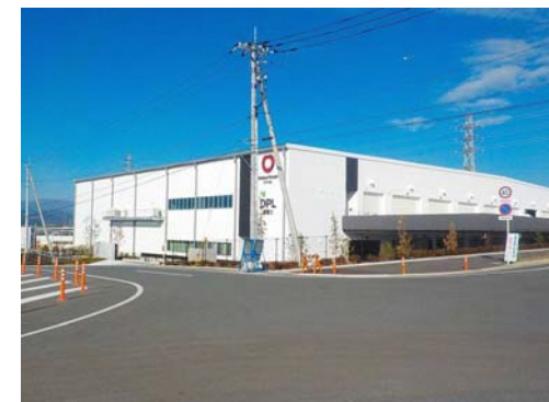
県内初となる複数事業者が入居可能なマルチテナント型物流施設（富士市）
