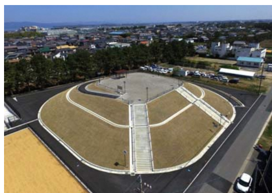
津波避難マウント（命山）の整備（湖西市）
