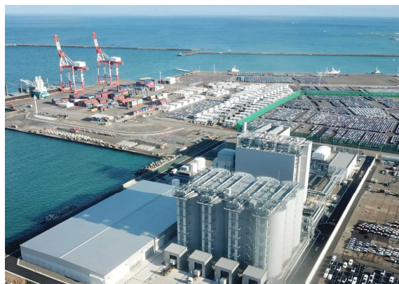
御前崎港バイオマス工場（御前崎市）
