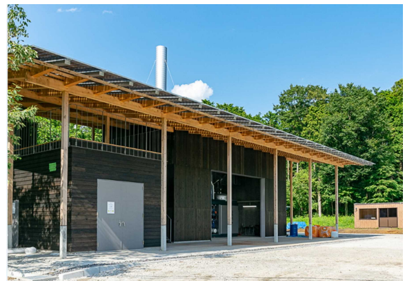
木質バイオマス発電所（小山町）
