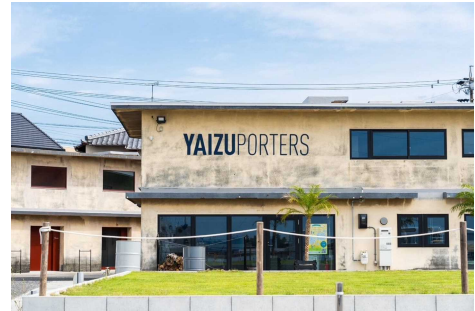
リノベーションした漁具倉庫
