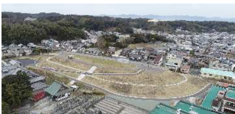
急傾斜地の切土工事による津波避難場所の整備 (湖西市 上田町地区)
