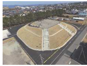
発生土を活用し命山を整備 (湖西市 住吉地区)
