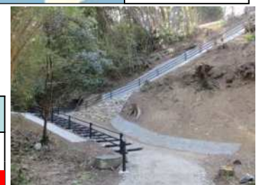
津波避難路となる観光遊歩道
