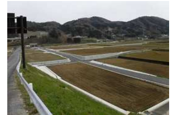
農業基盤整備完了
