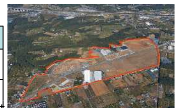
造成完了した第三都田工場用地
