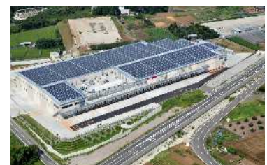
災害に強い物流施設
