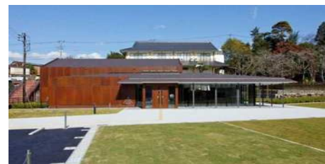
韮山反射炉ガイダンスセンター 整備完了
