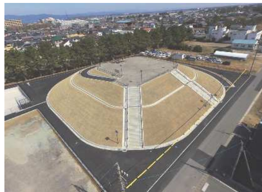
【湖西市】発生した土砂を利用して整備した命山（住吉地区）
