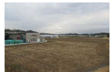
農地造成工事完了
