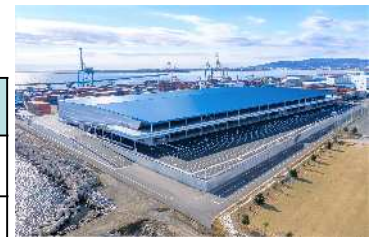
Lv2津波にも対応する物流施設
