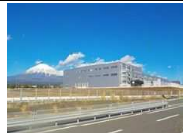
完成した大規模物流施設
