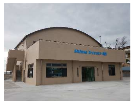
初島漁港交流広場・休憩施設完成
