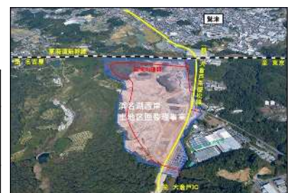
浜名湖西岸地区造成状況
