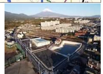
御宿地区住宅団地造成状況
