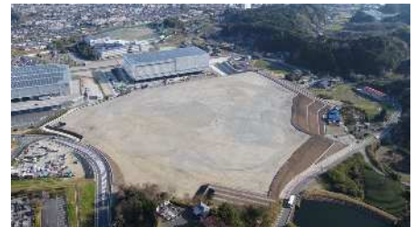
南西郷地区工業団地造成完了
