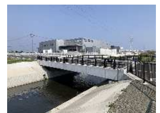
工業団地整備完了
