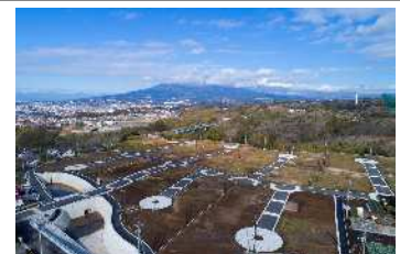
三島塚原地区住宅団地造成完了
