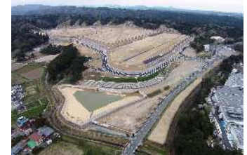
下野部工業団地造成完了
