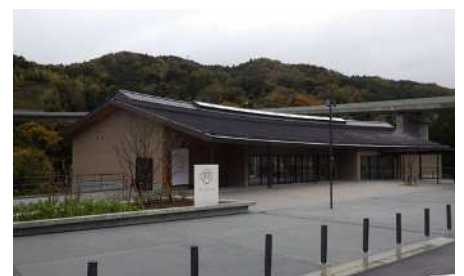
道の駅「伊豆月ヶ瀬」完成
