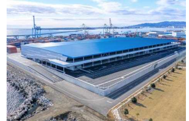
Lv2津波にも対応する物流施設
