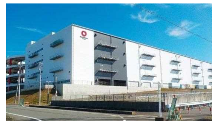
完成した大規模物流施設
