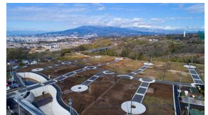
三島塚原地区住宅団地造成完了
