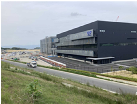
車載用電池生産工場の建設状況
