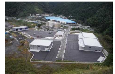
整備された物流団地
