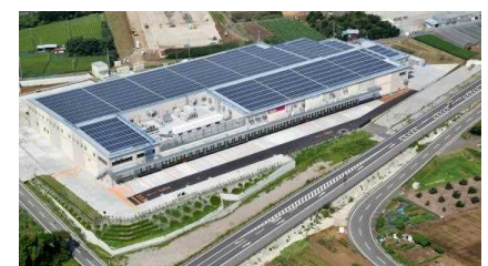
災害に強い物流施設
