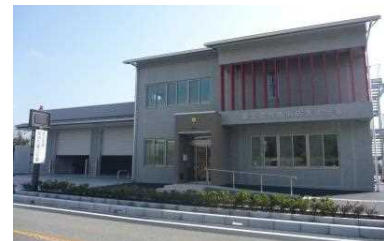
西消防署北分署の建設
