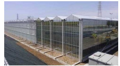
太陽光利用型施設園芸団地 (パプリカハウス)
