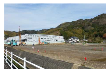
造成された物流団地(北側工区)
