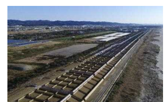
防潮堤の整備
