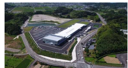
西工区(大坂・土方工業用地)整備状況
