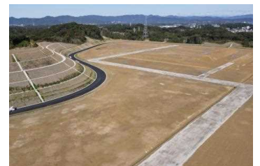
浜名湖西岸地区造成状況
