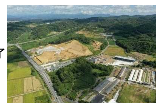
工業団地造成状況
