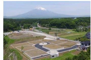
造成が完了した住宅地
