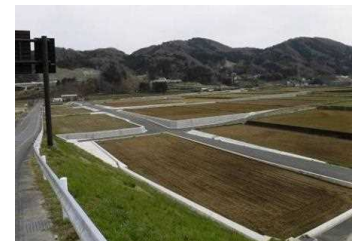
農業基盤整備完了
