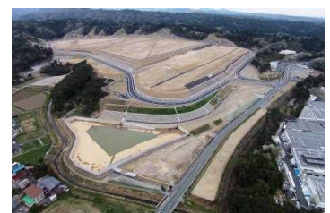
下野部工業団地造成完了
