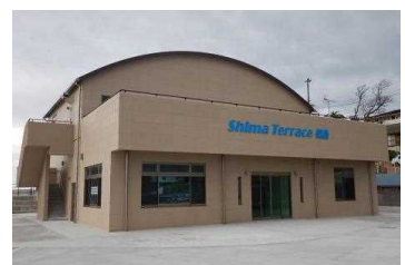
初島漁港交流広場・休憩施設
