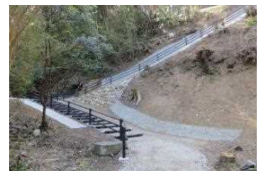
津波避難路となる観光遊歩道
