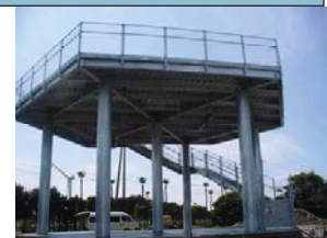
津波避難タワー
