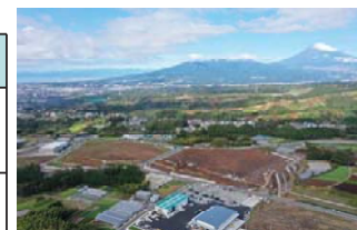
三ツ谷工業団地造成完了
