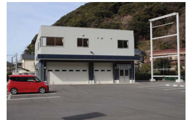
消防団詰所整備完了
