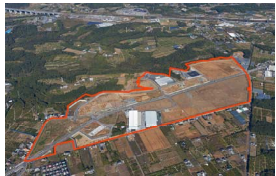
【浜松市】造成が完了した第三都田地区工場用地
