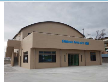
初島漁港交流広場・休憩施設完成
