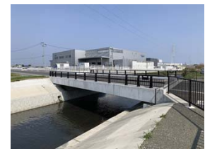
工業団地整備完了
