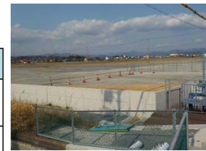
工業団地造成完了
