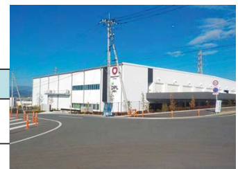
完成した物流施設
