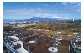
三島塚原地区住宅団地造成完了
