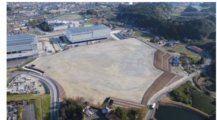
南西郷地区工業団地造成完了
