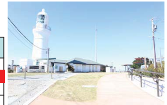
灯台周辺施設整備完了
