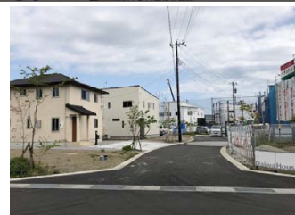
大場地区住宅団地
