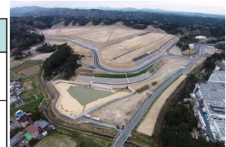
下野部工業団地造成完了
