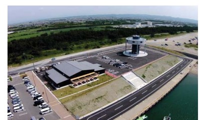
渚の交流館と津波避難タワー
