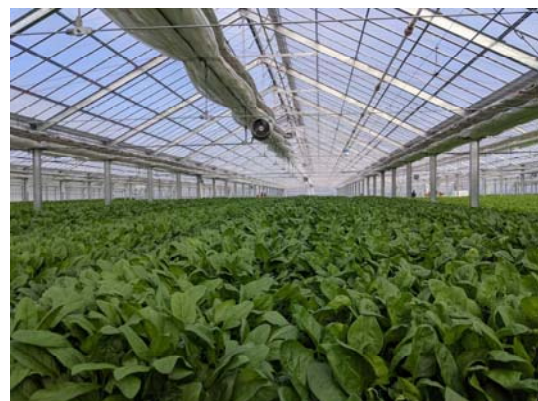
【磐田市】完成した太陽光利用型植物工場
