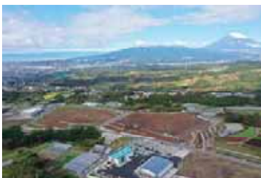
【三島市】三ツ谷工業団地 (完成)
