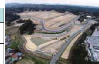
下野部工業団地造成完了
