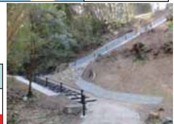
津波避難路となる観光遊歩道
