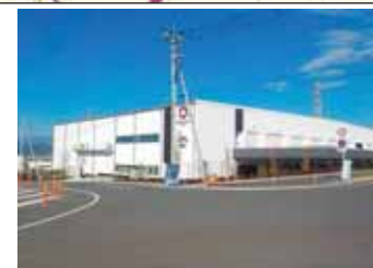
完成した物流施設
