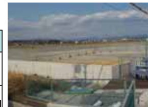
工業団地造成完了
