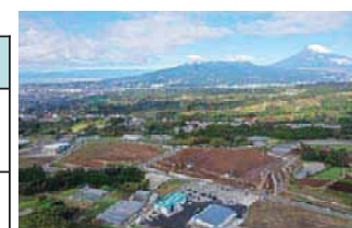
三ツ谷工業団地造成完了
