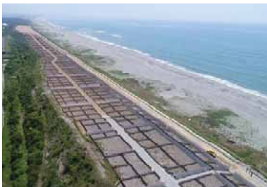
【袋井市】整備が進む静岡モデル防潮堤
