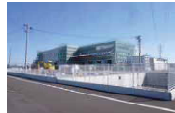
建築が進む工業団地
