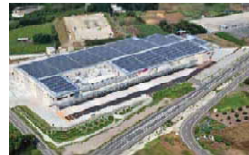
災害に強い物流施設
