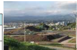
南西郷地区工業団地(造成中)
