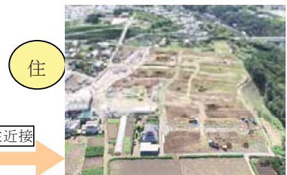
【三島市】三島塚原住宅地 (造成中)
