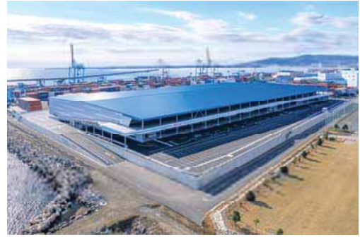
【静岡市】新興津国際物流センター 完成
