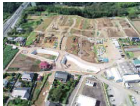
【三島市】造成が進む三島塚原地区住宅地
