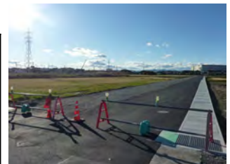
造成が進む工業団地
