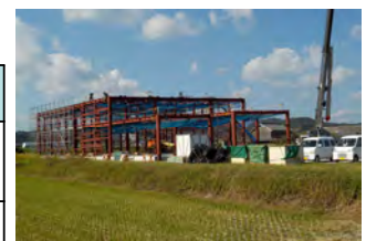
建設中の工場(製造業)
