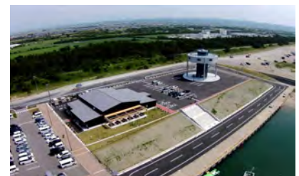
渚の交流館と津波避難タワー
