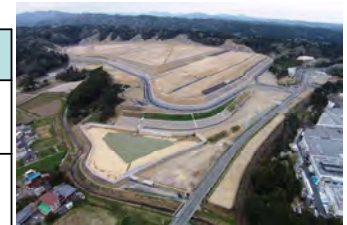
下野部工業団地造成完了
