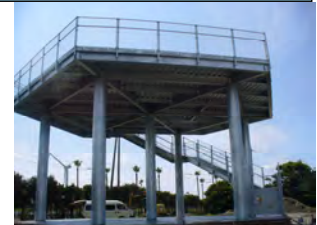
津波避難タワー
