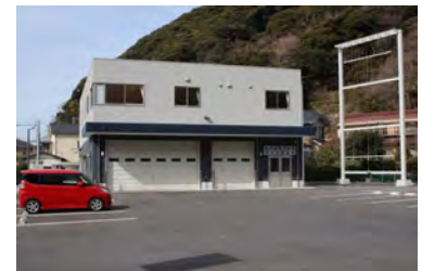
消防団詰所整備完了
