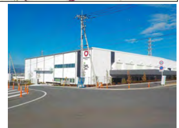
完成した物流施設
