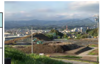
南西郷地区工業団地(造成中)
