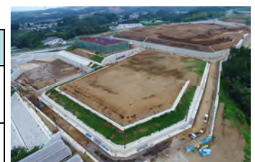
三ツ谷工業団地(造成中)
