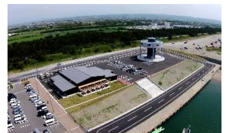
渚の交流館と津波避難タワー
