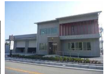
西消防署北分署の建設
