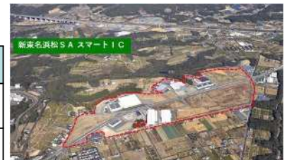
造成完了した第三都田地区工場用地
