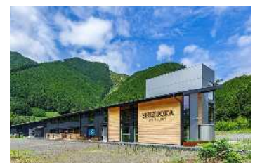
地域資源(麦芽、仕込み水)を活用したウイスキーの製造工場
