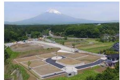
造成が完了した住宅地
