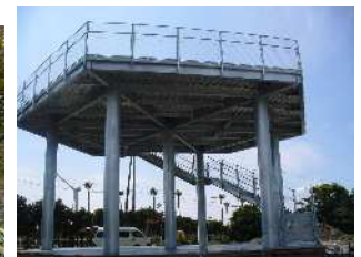
津波避難タワー
