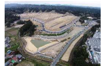
下野部工業団地造成完了
