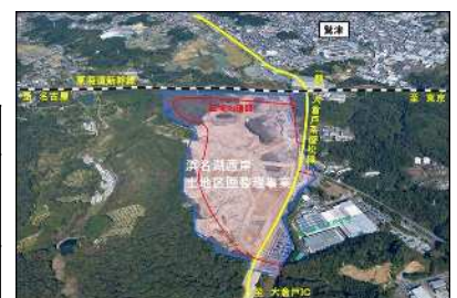
浜名湖西岸地区造成状況
