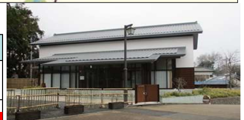
整備された江川文庫収蔵庫
