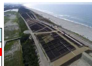
防潮堤整備状況
