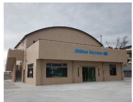
初島漁港交流広場・休憩施設完成
