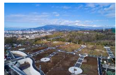
三島塚原地区住宅団地造成完了
