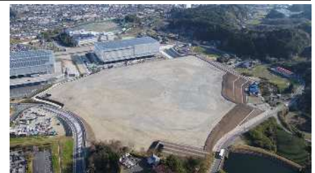
南西郷地区工業団地造成完了
