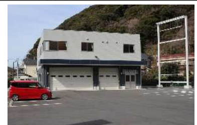
消防団詰所整備完了
