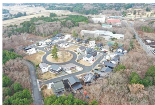
■自然豊かな「富士小山わさび平住宅団地」（小山町）
