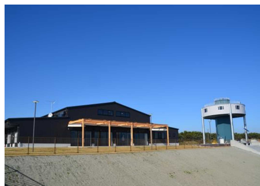
■漁港周辺における食の拠点と津波避難タワー（磐田市）
