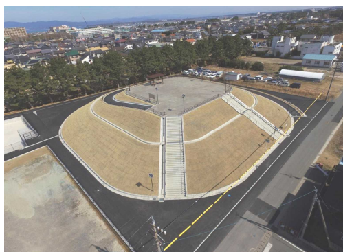
■急傾斜地対策事業により発生した土砂を利用し沿岸部に整備した命山（湖西市）
