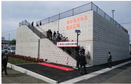
左：高台(防災広場)の整備
