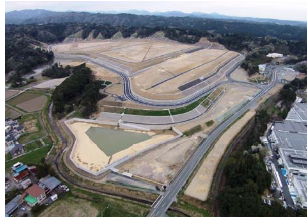
写真 13 新東名高速道路 SIC に近接する工業団地
