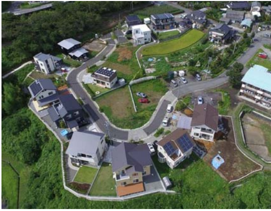
写真 12 自然と調和した豊かな暮らし空間を実現する住宅団地
