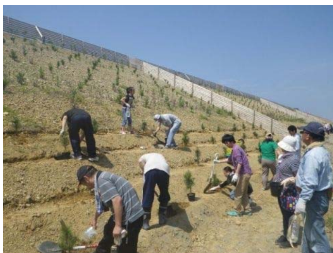
写真4 “ふじのくに森の防潮堤づくり”の植林状況
