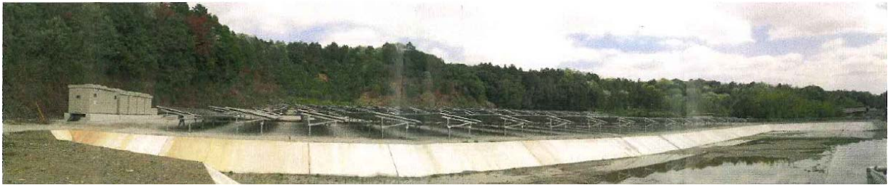
太陽光発電施設
