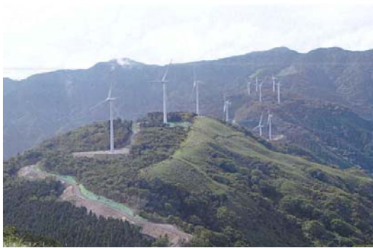
東伊豆風力発電所(東京電力)
