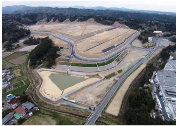
写真 12 新東名高速道路 SIC に近接する工業団地
