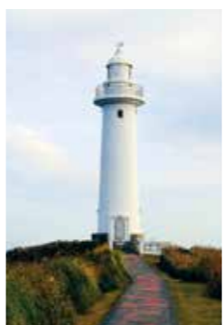
昭和12(1937)年に設置された爪木崎灯台。高さ17.3m、白色塔形のコンクリート造。
