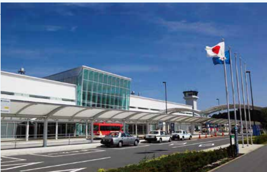
ターミナルビル増改築予定の 富士山静岡空港。
