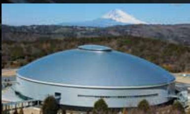
国内有数の自転車競技施設と言われる「ペロドローム」(伊豆市)。傾斜45度のトラックで行われるレースはスピード感と迫りに満ちている。
