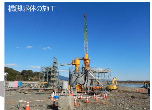
刃口内部の掘削状況
