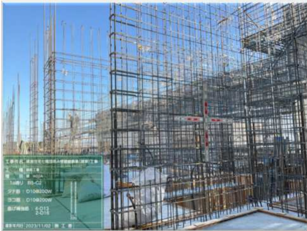
次は「骨組み」の工事。骨組みは「躯体（くたい）」と呼ばれている。鉄筋とコンクリートでつくる。写真は鉄筋を組んでいる様子。
