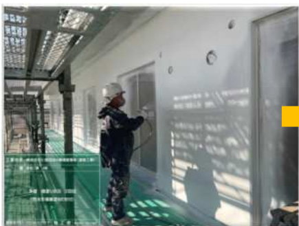
外壁を塗装したり・・・
