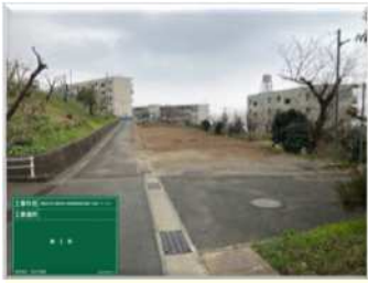
何も無いところから 工事スタート！
