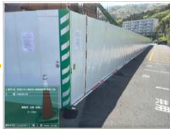
まずは「仮囲い」という 侵入防止の安全対策
