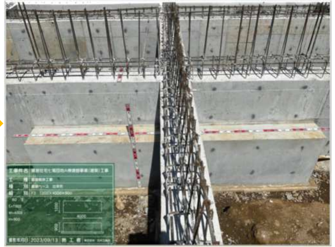
一番初めに建物の土台をつくる。土台は「基礎（きそ）」と言う。地面と建物をつないで、建物を支える役割がある。
