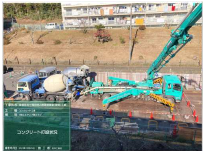
コンクリートミキサー車と圧送車。高いところにコンクリートを送るために長いホースのついた車を配備する。
