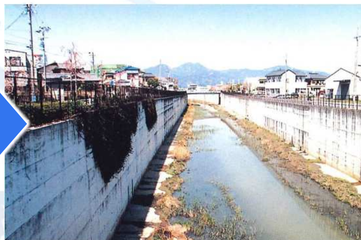
大谷川放水路完成
