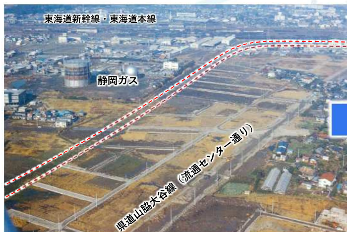
工事前の大谷川放水路（昭和47年）
